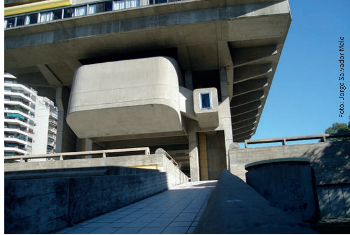
Biblioteca Nacional. Obra de Alicia Cazzaniga, Francisco Bullrich y Clorindo Testa. 1962/1992.
